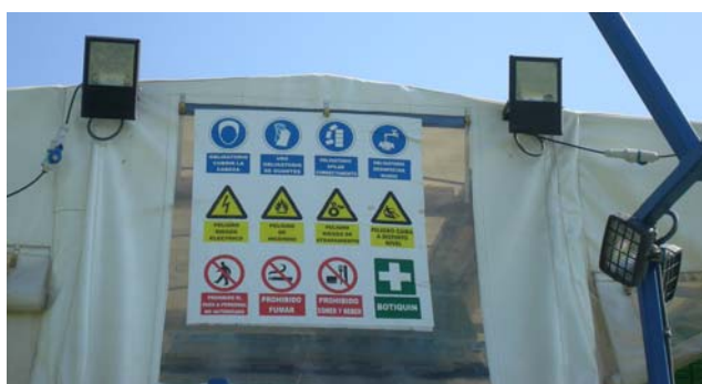
Cartel de señalización de seguridad
