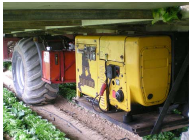
Grupo electrógeno instalado en una plataforma
