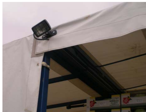
Fuente de alumbrado exterior
